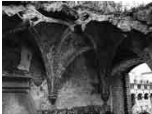
3 Reste der Netzgewölbe im nördlichen Saal des Erdgeschosses (Foto 1959).
